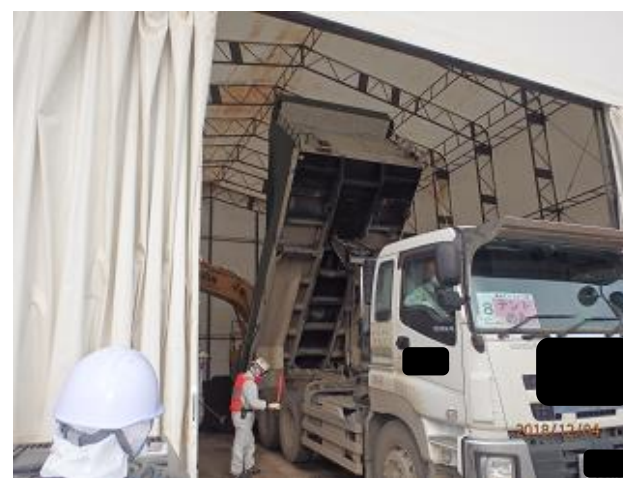
除去土壌の搬入状況の確認
