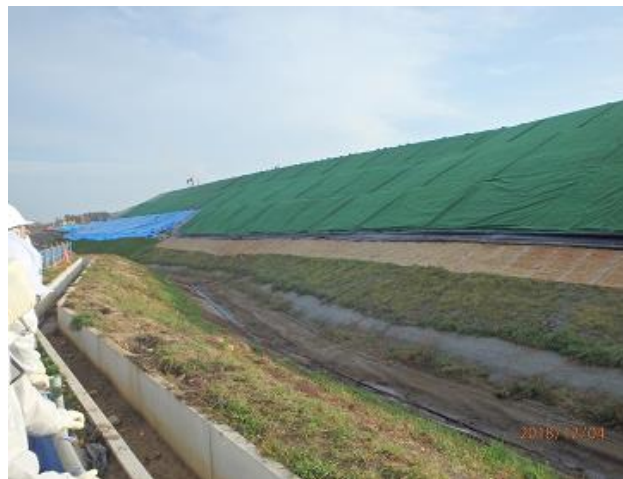
土壌貯蔵施設の法面の状況の確認
