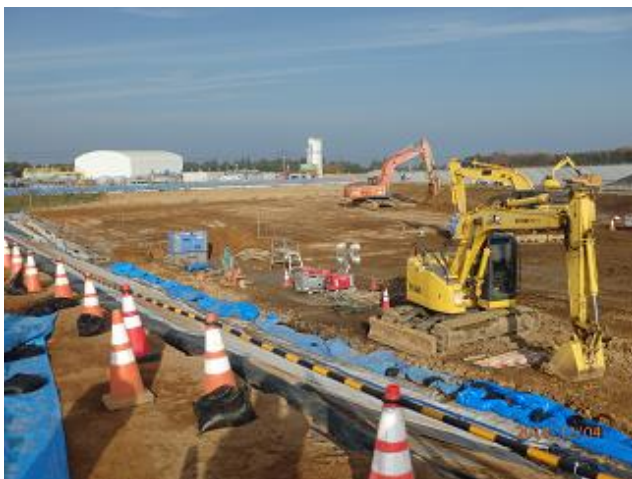
土壌貯蔵施設の設置状況の確認
