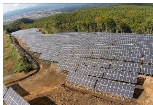
雄国発電所（喜多方市）
