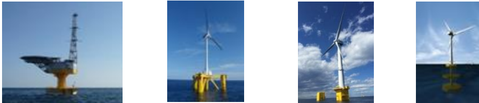
浮体式洋上風力発電実証事業における洋上変電所と洋上風車
