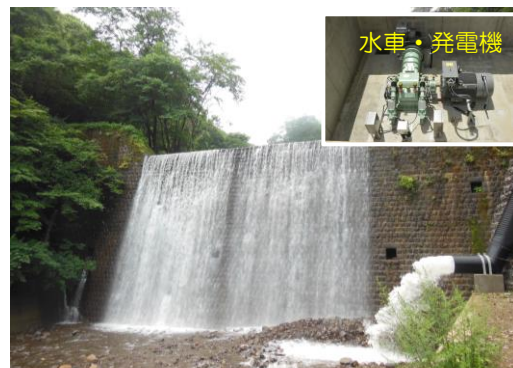
土湯温泉東鴉川水力発電所（福島市）
