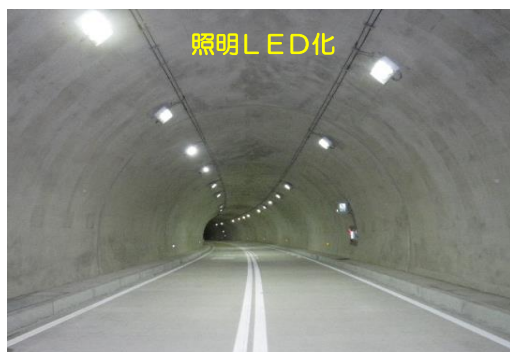
国道252号 滝トンネル（金山町）
