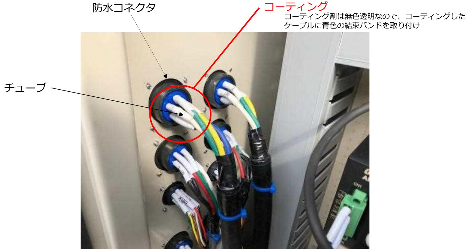
チューブ取り付け前にコーティングを実施し、チューブ取り付け後に再度コーティングを実施
