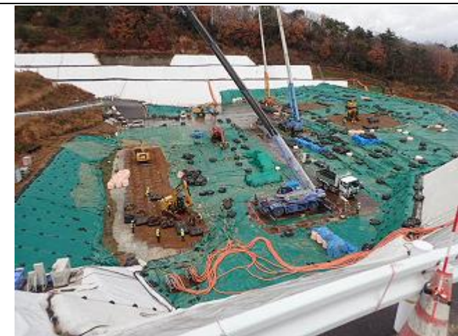
サンプリング当日の埋立作業の状況
