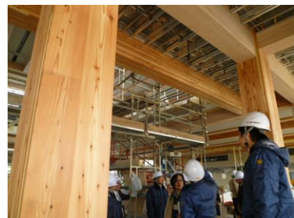
現地研修(国見町新庁舎建物内部)
