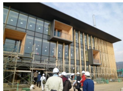
現地研修(国見町新庁舎建物外部)
