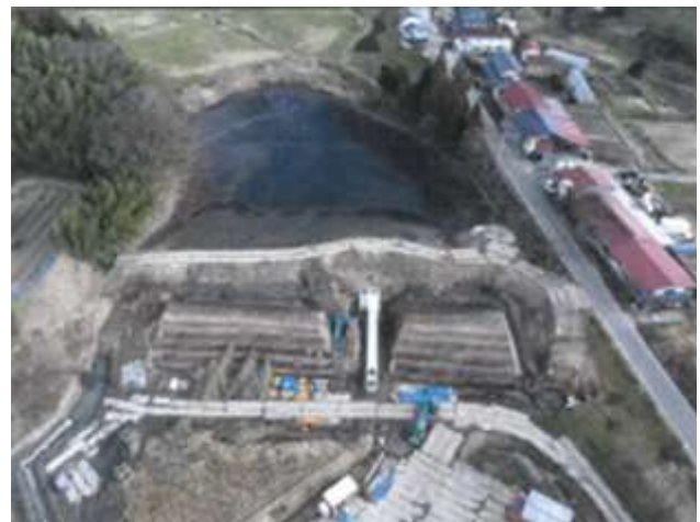
後藤技師が担当のため池工事の実施状況写真
