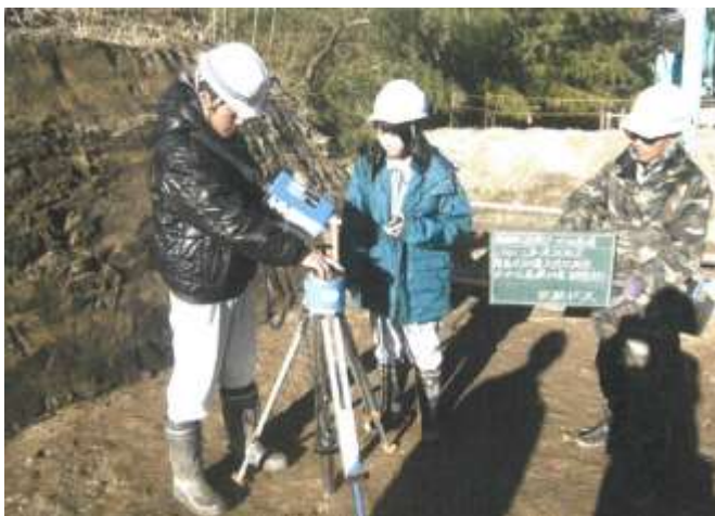
地盤支持力を確認している農村整備部の後藤技師
