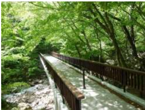
駐車場から本流を渡る歩道橋
