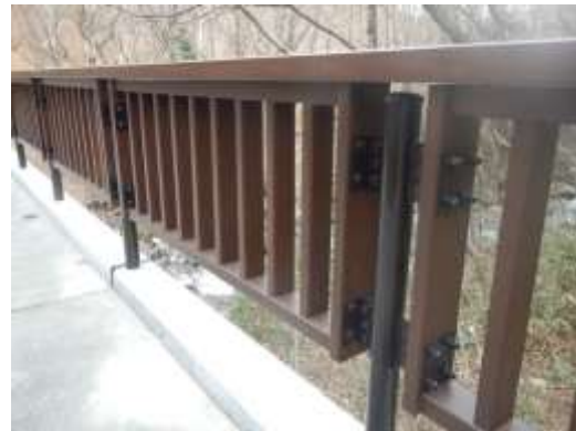
ガラス質コーティングされた木製欄干
