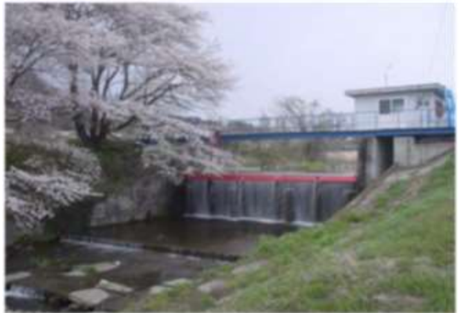
芝堤頭首工(現在のしがらみのダム)
