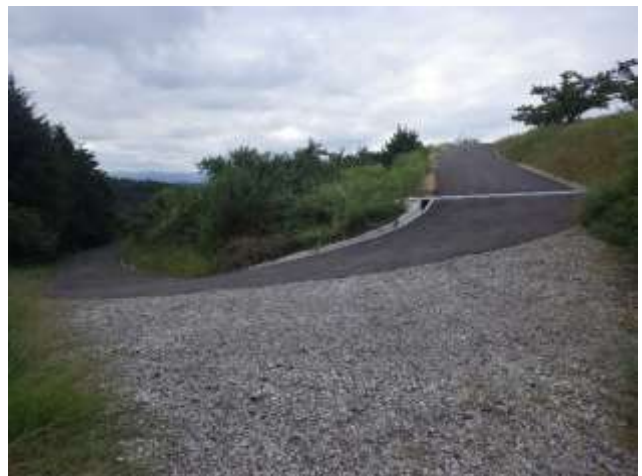
舗装された道路(工事後)
