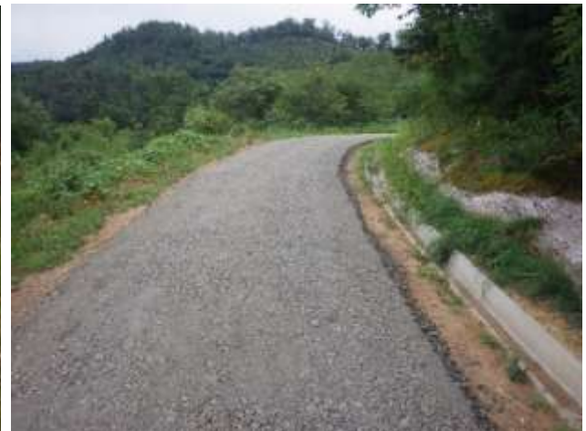
排水路を整備(工事後)
