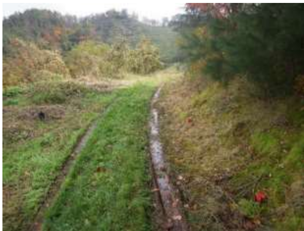
排水路が無い状態(工事前)
