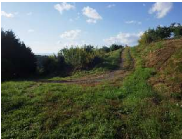
狭く急な砂利道(工事前)
