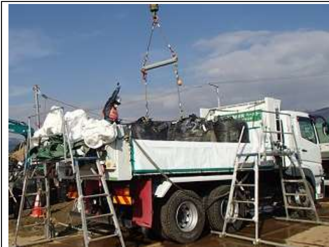
輸送物の積込作業確認
