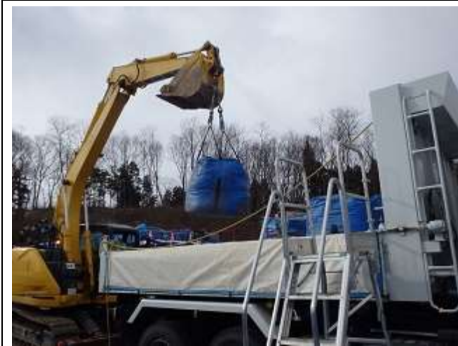
輸送物の積込作業確認
