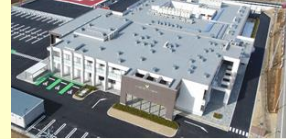
福岛县双叶医疗中心附属医院
