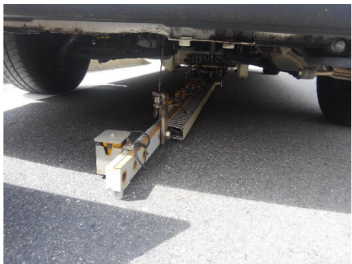
写真1 FWD試験の実施状況
