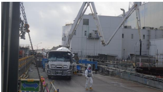
(写真2-1) 3槽目のピットの配管内に生コンを打設している様子①
