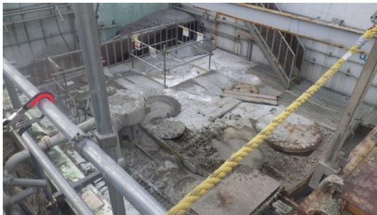
(写真1) 2槽目のピット内の様子
