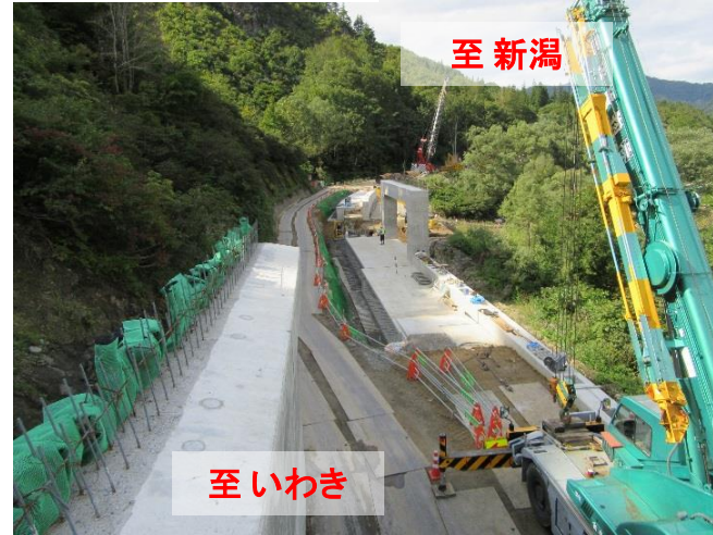
スノーシート工事状況
