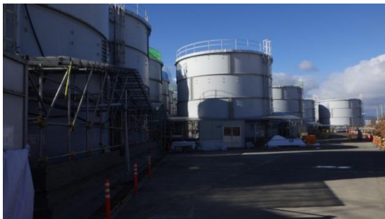
(写真1-1) Eタンクエリア
