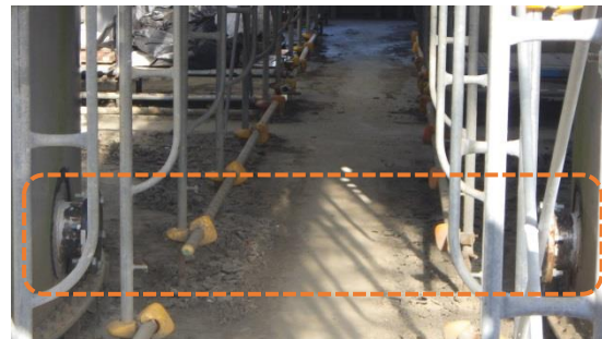
(写真1-2) 撤去されたタンクの連結管
