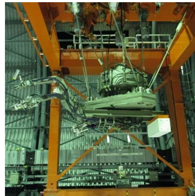
テンシルトラス吊り上げ状態
