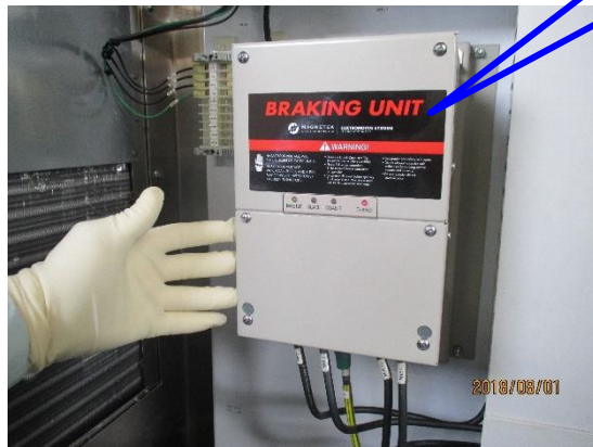
ブレーキユニットの外観 (交換後)
