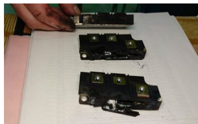
損傷の確認された整流器 (4月5日)
