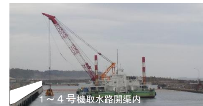
海側遮水壁防衝盛土工事の様子
