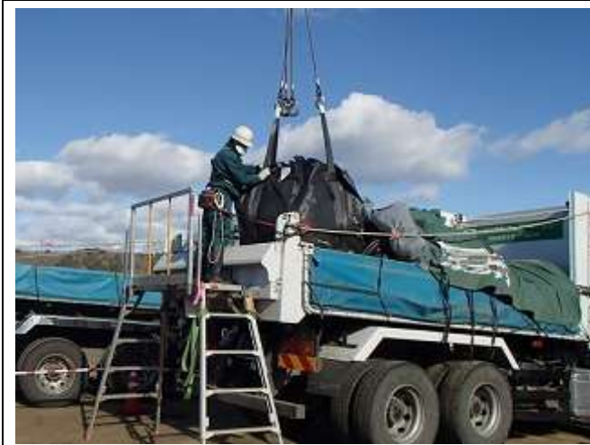
輸送物の積込作業確認
