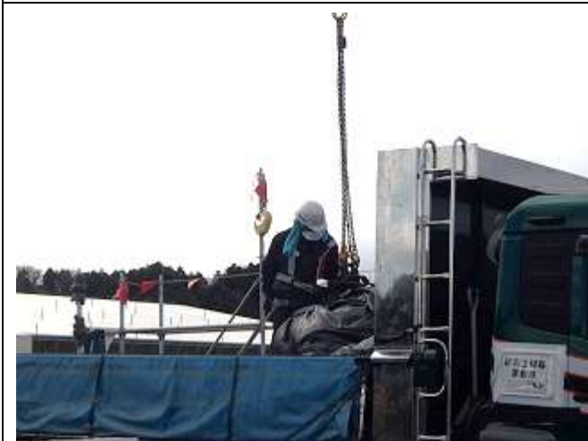
輸送物の荷下し作業確認
