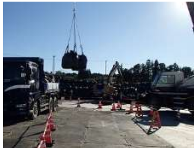
保管場荷下ろし状況確認
