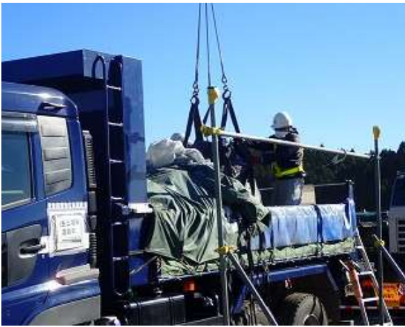
輸送物の積込作業確認
