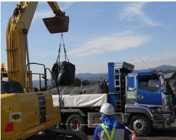
輸送物の積込作業確認
