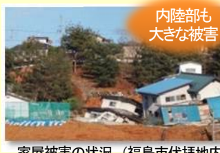
家屋被害の状況（福島市伏拝地内）
