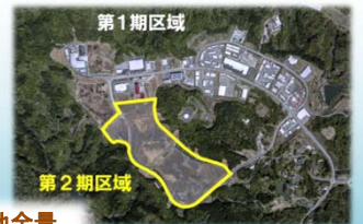
工業団地全景
