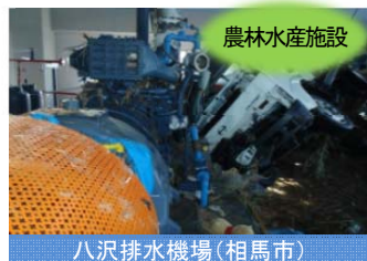
八沢排水機場（相馬市）
