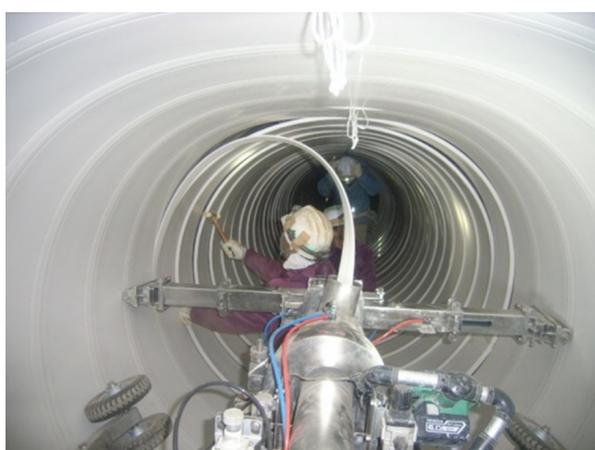
地下で行われている工事の様子
