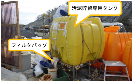
(写真 2 - 1) 汚泥の抜き出し作業の状況
