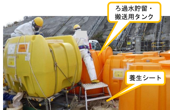
(写真 3 - 2) ろ過水の貯留作業の状況
