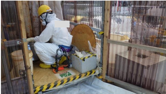
(写真 3 - 1) ろ過水の汲み上げ作業の状況
