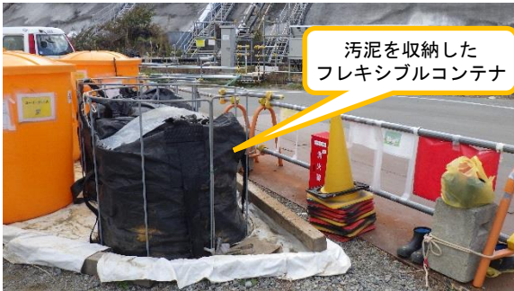
(写真 4) 乾燥した汚泥の一時保管の状況
