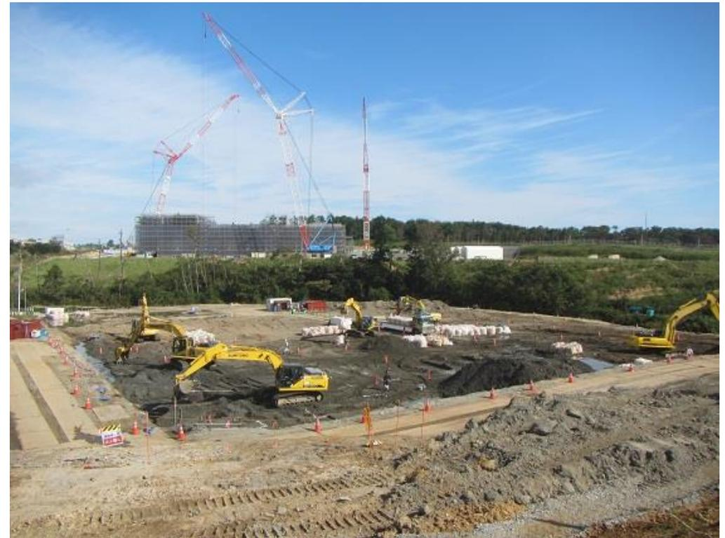
バックホウを用いた基礎下及び土間下地盤改良状況
