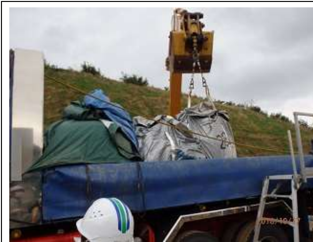
輸送物の積込作業確認
