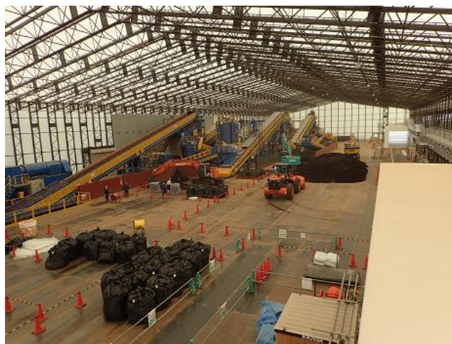
受入・分別施設の稼働状況の確認
