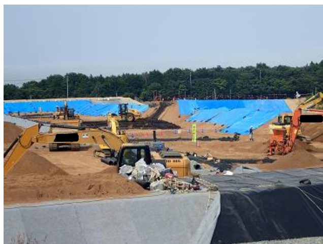
土壌貯蔵施設の設置状況の確認
