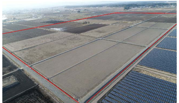
「ほ場整備工事完成後」
