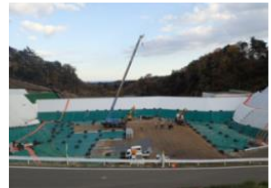
埋立処分施設の状況
