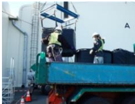
輸送車両への廃棄物積込状況
