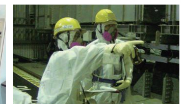
▲3号機建屋の確認
