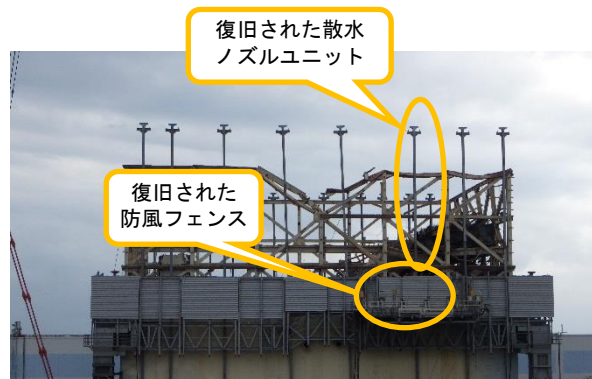
(写真2) 西面の防風フェンス及び散水ノズルユニットの復旧状況
