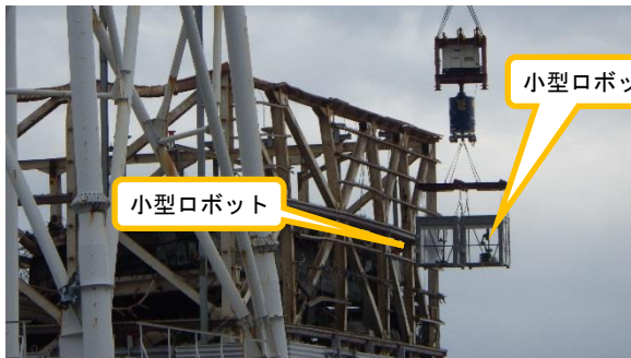
(写真1-2) 小型ロボット回収用コンテナの吊り上げ状況
