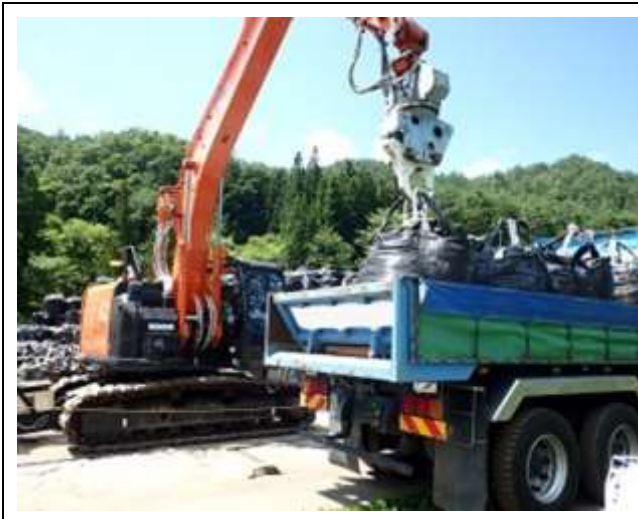
輸送物の積込作業確認
