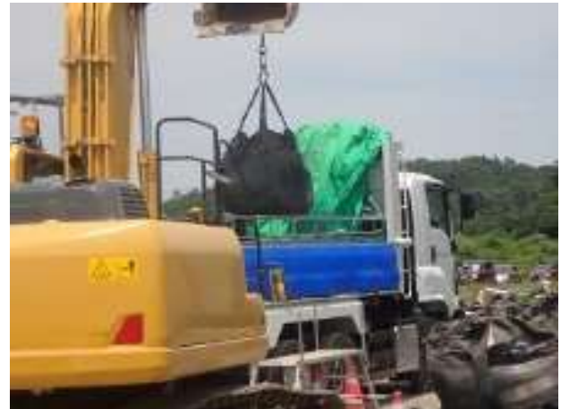
輸送物の積込作業確認
