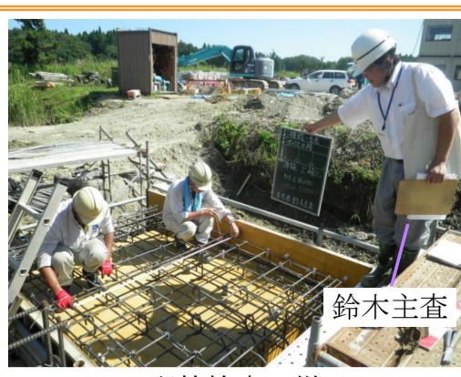
配筋検査の様子
