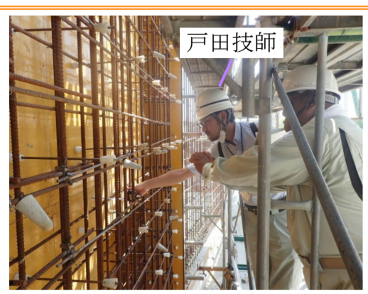
型枠検査の様子
