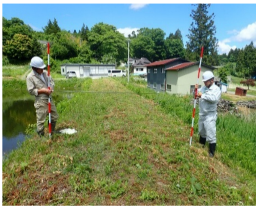
ため池天端幅を確認中
