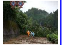
災害により通行できなくなった道路
