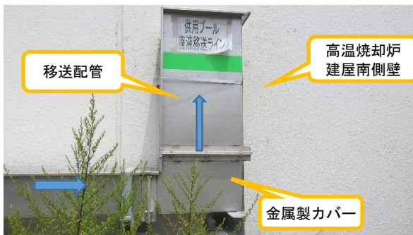
(写真2-2) 移送配管の敷設状況④ (高温焼却炉建屋南側壁入口配管)
