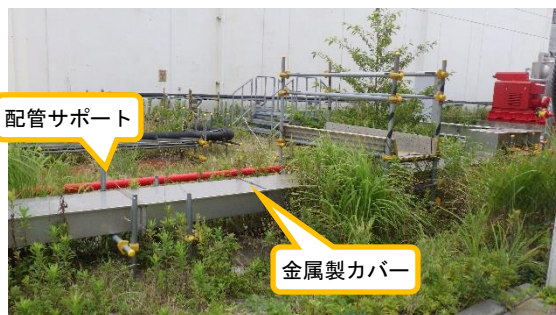
（写真1-1）移送配管の敷設状況① （共用プール建屋～高温焼却炉建屋間 北側から撮影）
