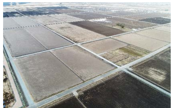
復興基盤総合整備事業 右田・海老地区(南相馬市) ほ場整備工事 竣工写真(平成30年3月撮影)
