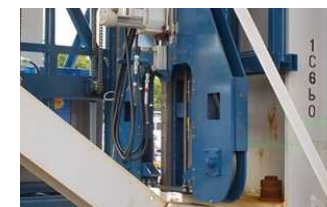
バンドソーによる切断
