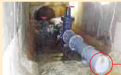
設置した 逆止弁
