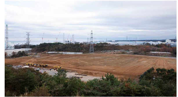
廃棄物保管等施設の設置予定地
