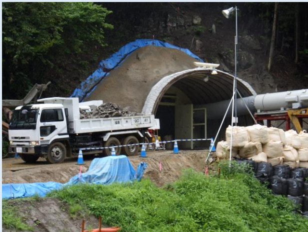
現場施工状況
