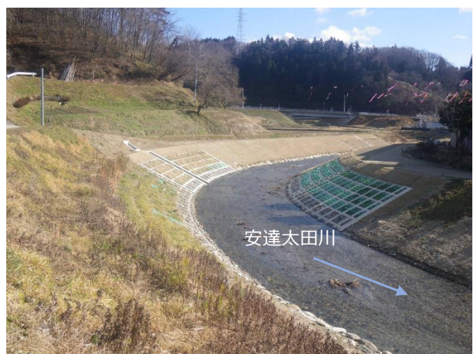
安達太田川（二本松市太田）開削護岸
