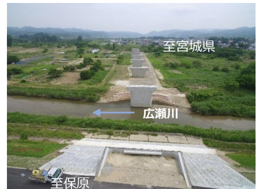
国道349号 梁川バイパス (伊達市梁川町)
