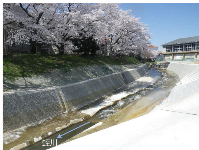
蛭川（福島市瀬上町）開削護岸
