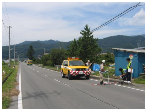
道路の異常を点検している様子
