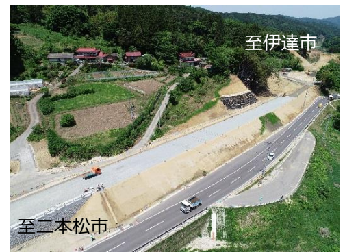
国道349号 大綱木1工区 (川俣町)
