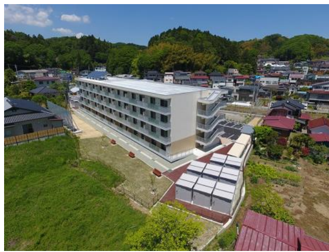
復興公営住宅 《若宮団地（二本松市）》 RC(PC)造4階建て32戸(H29.5.17竣工)
