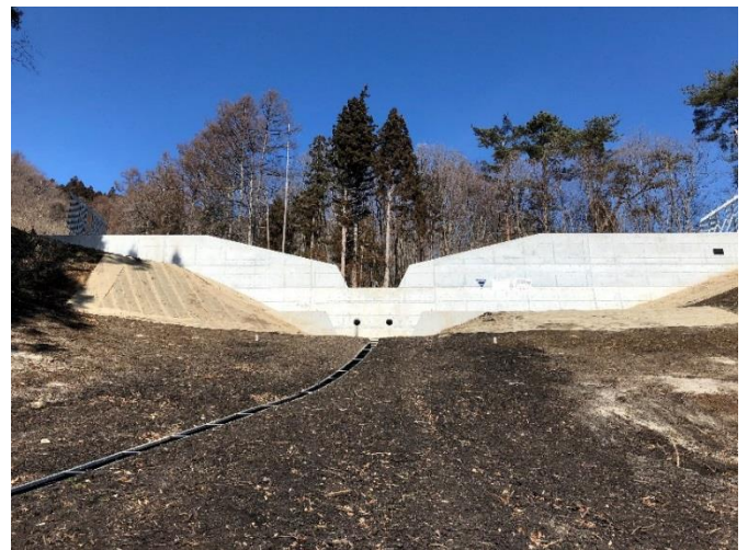
砂防えん堤（小戸屋沢筋） [二本松市百目木]
