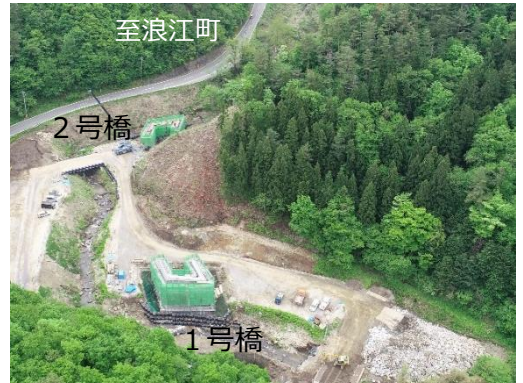
国道114号 山木屋1工区 (川俣町)
