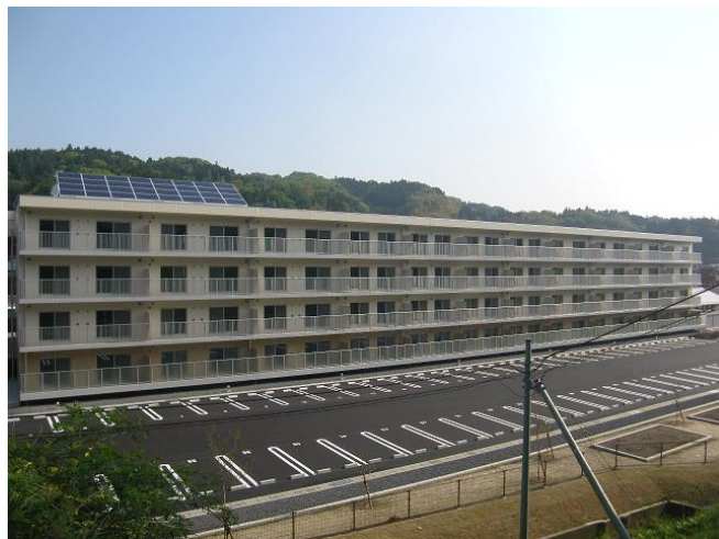
復興公営住宅 《表団地（二本松市）》 RC(PC)造4階建て44戸(H29.5.23竣工)
