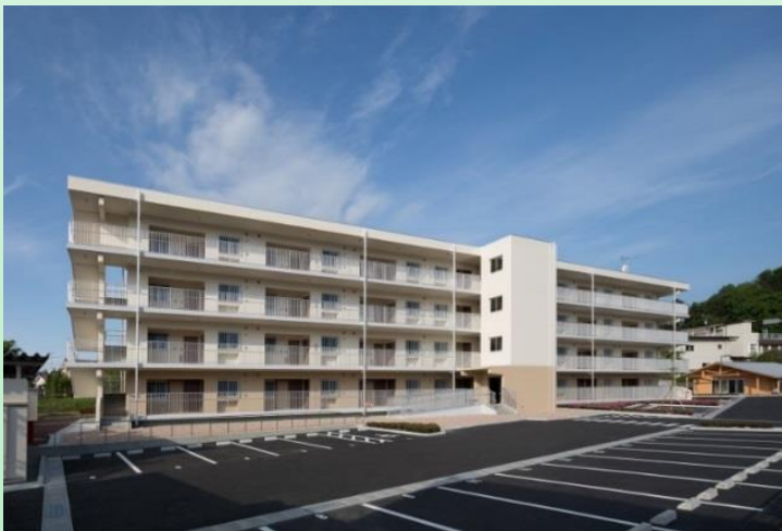
【「安らぎ」と「ゆとり」が持てる県民生活の確保】 復興公営住宅 若宮団地 H29.5月完了
