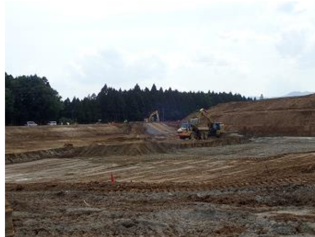
土壌貯蔵施設の設置状況の確認
