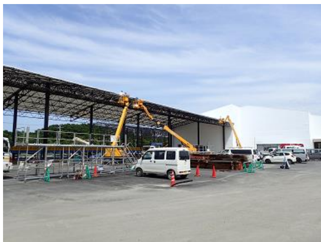
受入・分別施設の設置状況の確認
