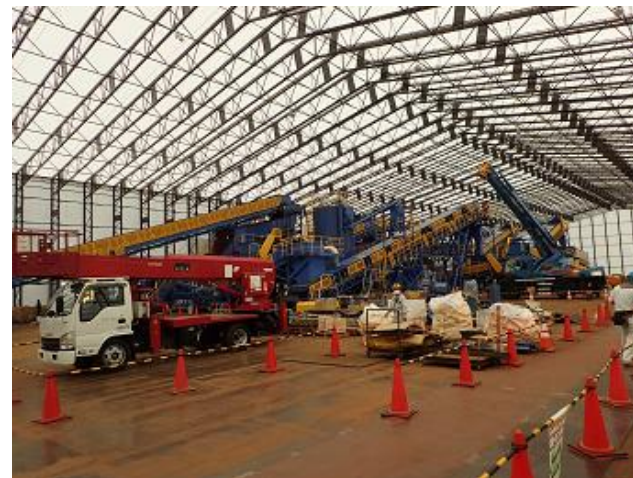
受入・分別施設の設置状況の確認
