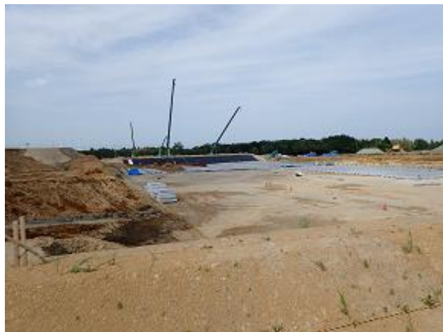
土壌貯蔵施設の設置状況の確認
