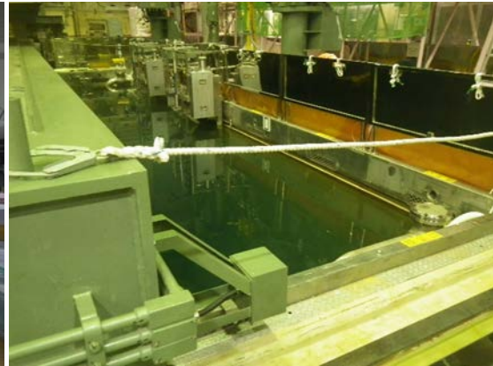
(写真4-2) 燃料プール
