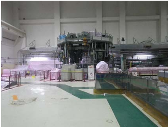
(写真4-1) オペレーティングフロアの状況
