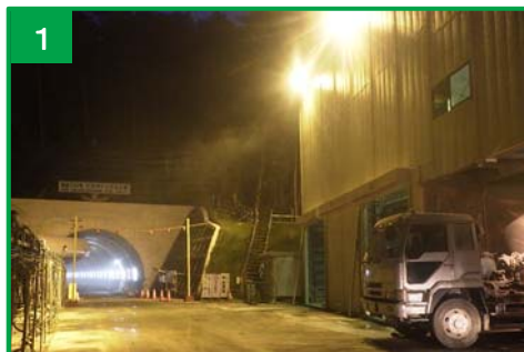
川内村側のトンネル抗口の状況(夜間)
