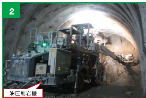
トンネル掘削の最先端の状況
