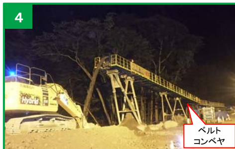
工事現場の仮置き場の状況(夜間)
