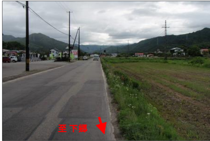
工事着手前 (平成22年度)
