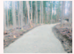
作業道の整備状況
