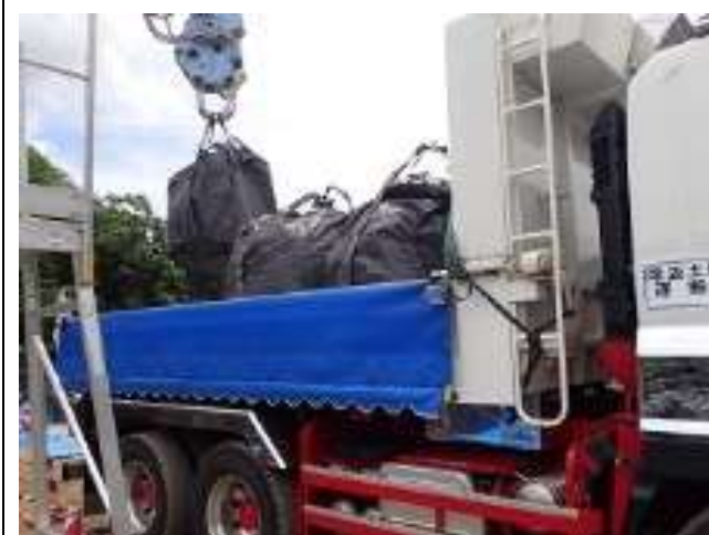
輸送物の積込作業確認
