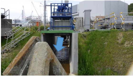
(写真 2 - 2) 排水口の状況
