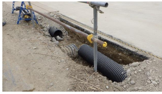
(写真3) 北側沿いの暗渠
