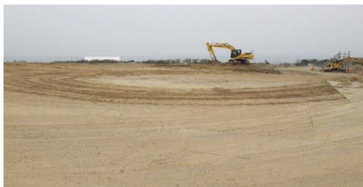
（写真1） 更地となった状況
