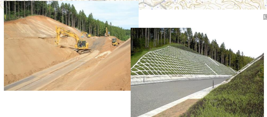
③青生野工区道路改良工事の様子と現在
