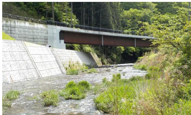
①(仮称)1号橋
