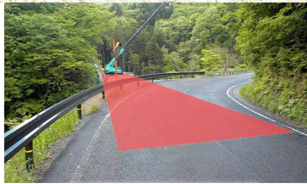
②(仮称)2号橋架橋地点
