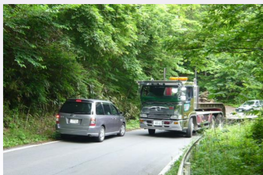
道幅が狭く大型車とのすれ違いが困難な箇所
