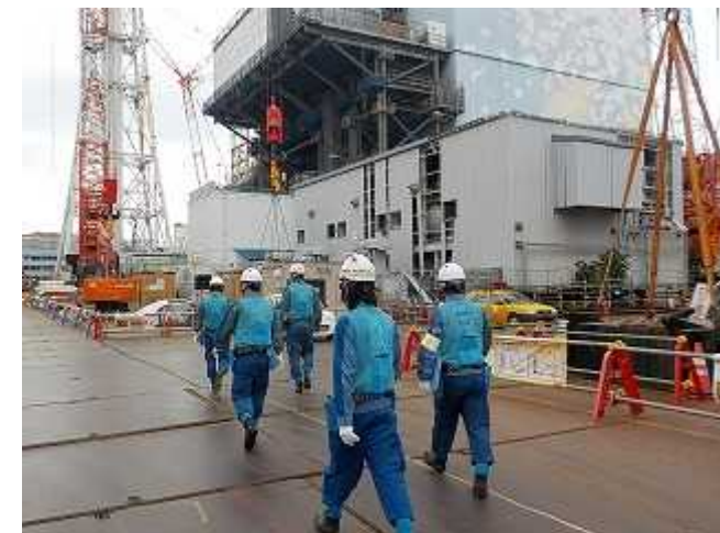
2号機山側道路
